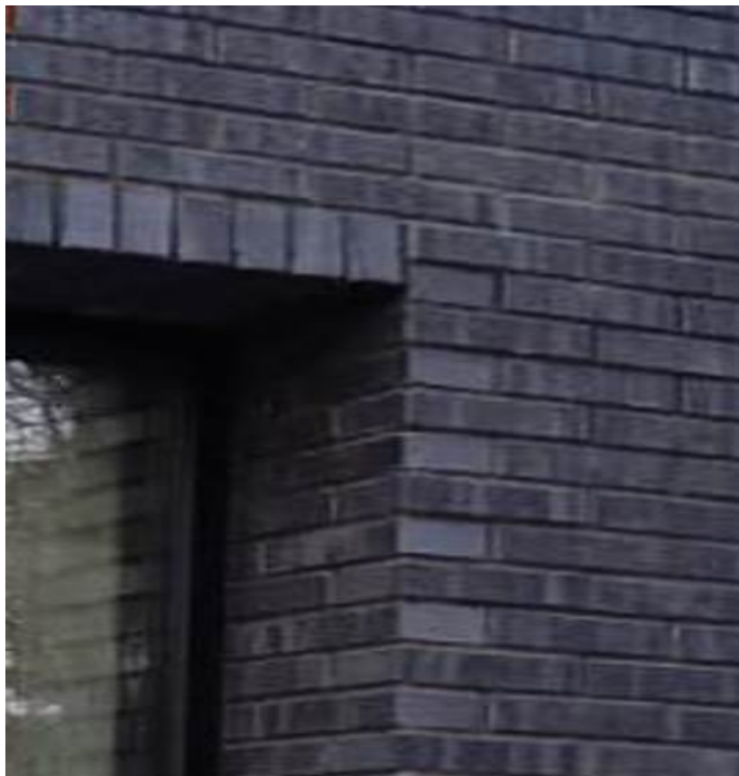
Рис.19 Оконное обрамление закрытого типа с облицовкой верхнего и боковых откосов кирпичом.
